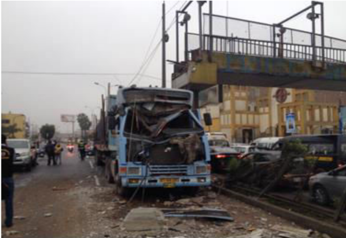
Figura N° 26: Caída de puente peatonal en Ate 03/11/15
