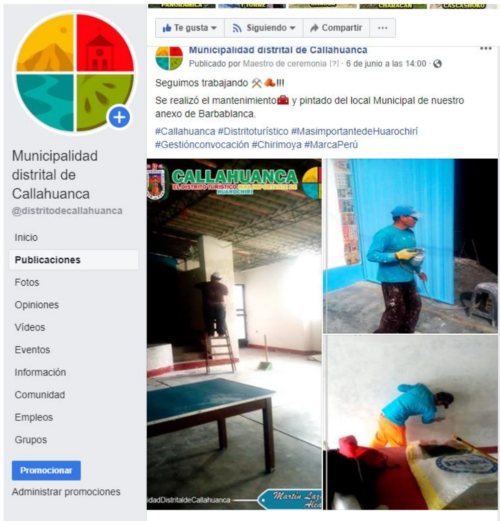
Leyenda: Publicación de los mejoramientos de las instalaciones de los locales comunales
